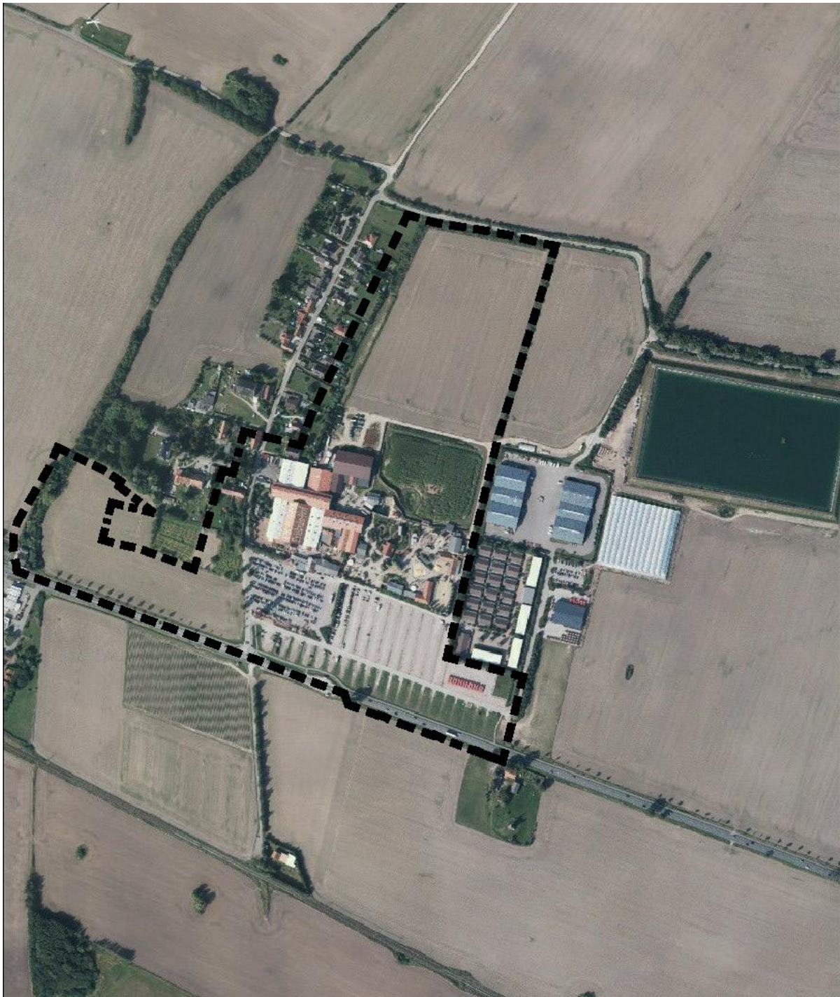
Luftbild i.M. Quelle: GeoPortal.MV 13.04.2021 bearbeitet ign Melzer & Voigtländer Ingenieure PartG-mbH
