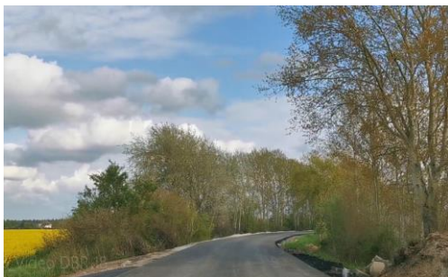
Blick in Richtung Bauende
