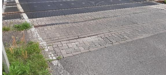
Bild 10: abgesackte Pflasterfläche im Bereich der Gleisquerung
