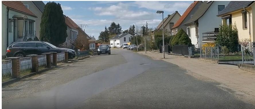
ca. 0+015 ausgemergelte Asphaltbefestigung, fehlende Entwässerung, Gehweg mit Unebenheiten niveaugleich, mit Betonplatten
