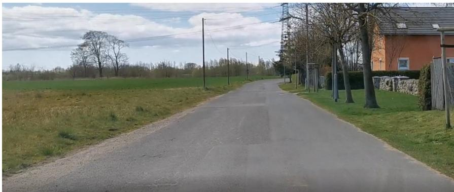
ca. 0+0225 ausgemergelte Asphaltbefestigung, Risse, Schlaglochbildung, fehlende Entwässerung
