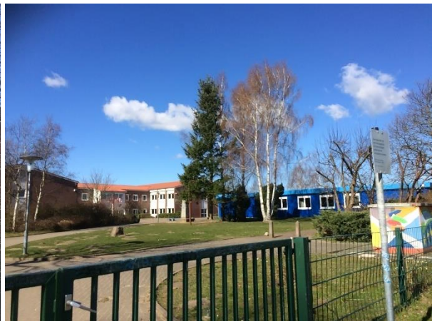
Foto 4: Schulgelände im südöstlichen Bereich
