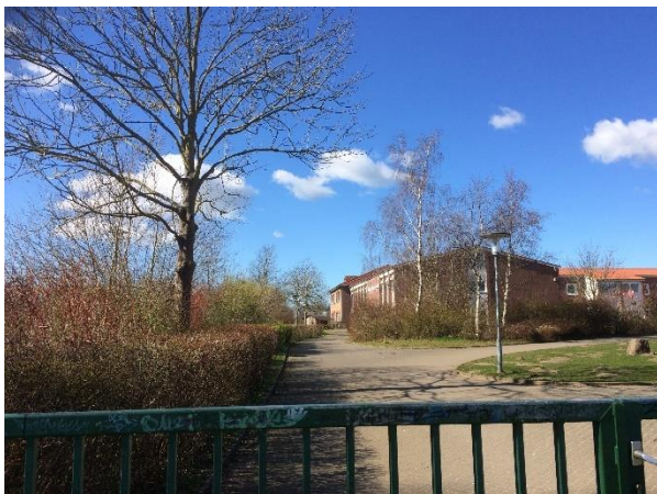
Foto 5: Hauptgebäude im südlichen Bereich
